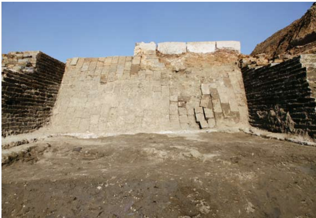
图八 挡水墙南坡面（南→北）
