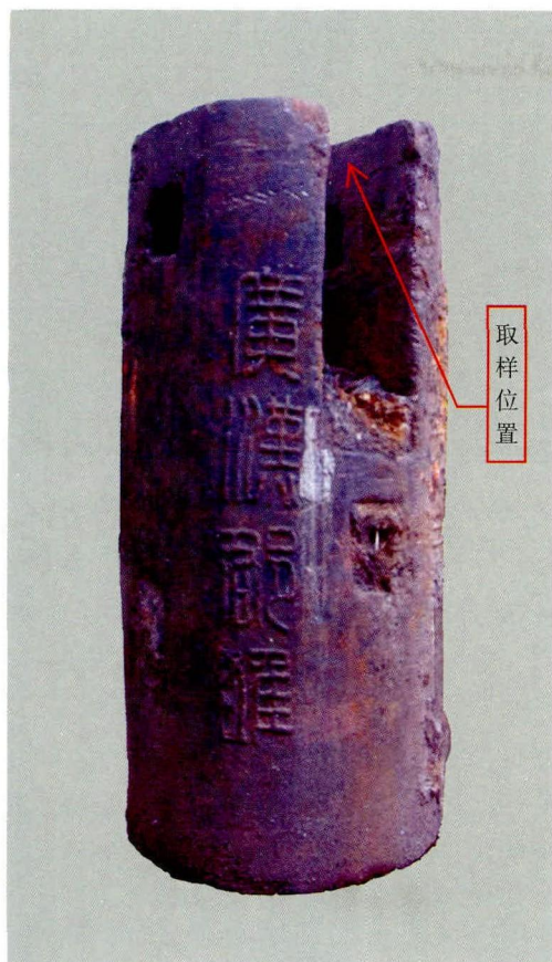
图四 雒江铁桥墩及取样位置
