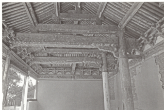
图九 文庙大成殿明间西缝梁架
