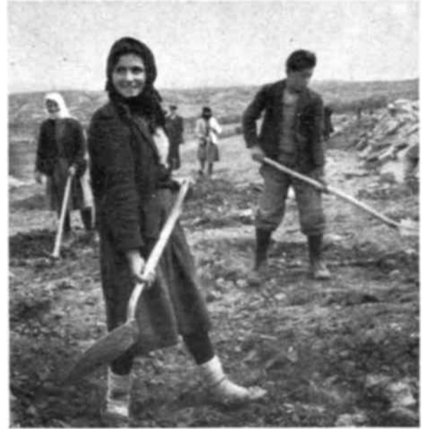
Construction de nouvelles routes en Grèce.
