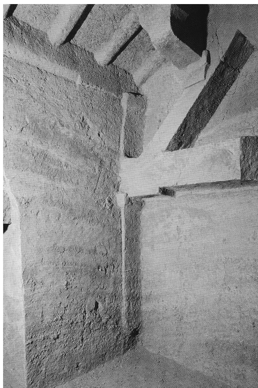
图三 M1 前室北壁梁架结构局部（前室西北隅） [6]
